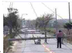
城辺町の電柱被害 写真:琉球新報社
